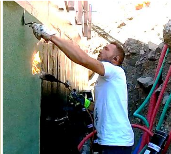
Prises de vue avec le maçon
