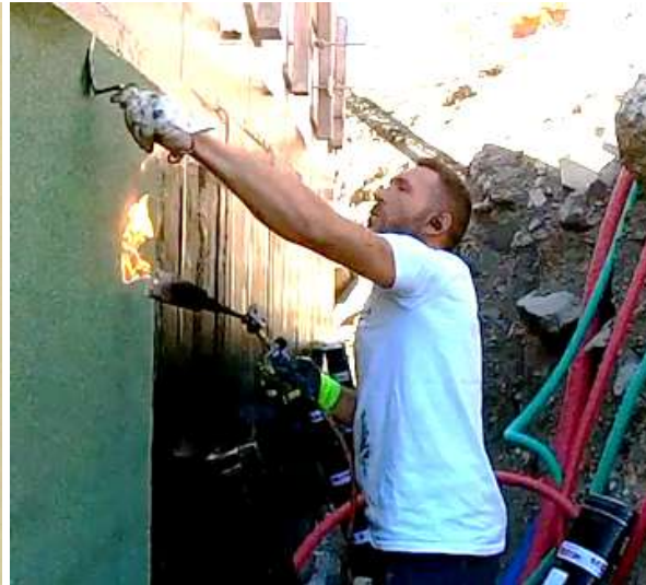
Prises de vue avec le maçon
