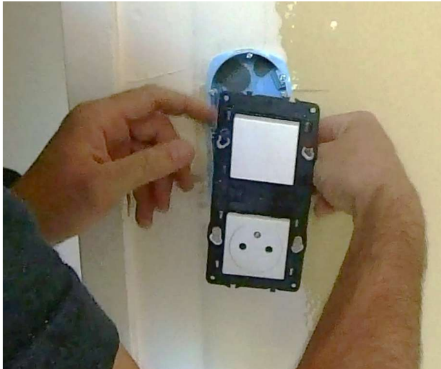
Prise de vue avec l'électricien
